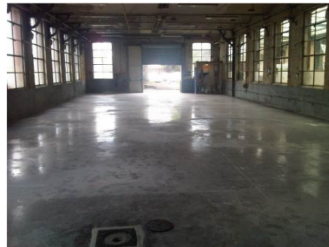
Vue du bâtiment 3 après réfection de la dalle
