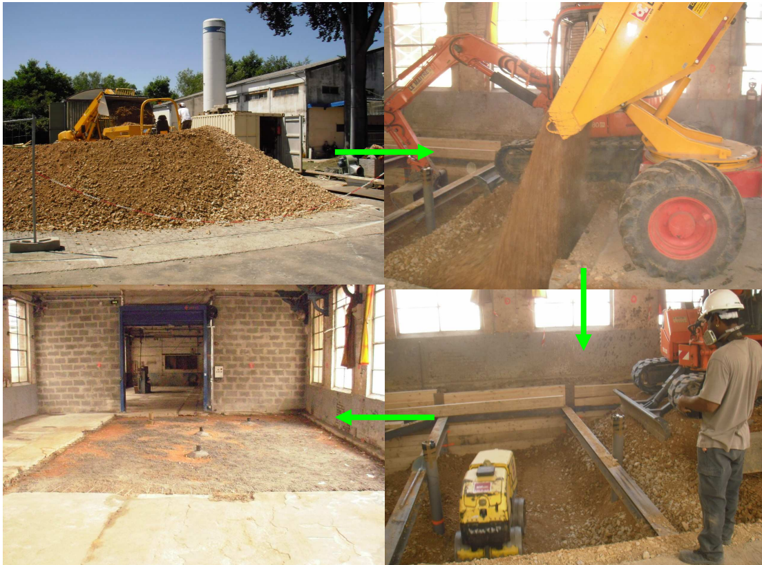
Figure 23 : Phasage remblaiement
