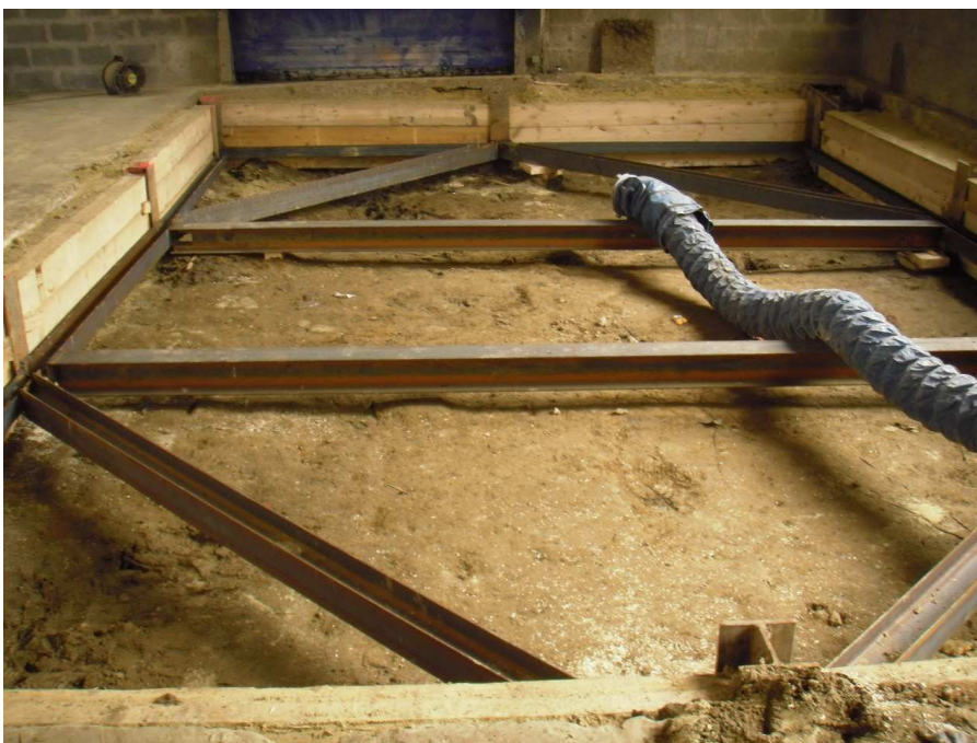
Figure 14 : Pré-terrassement et lit de butons
