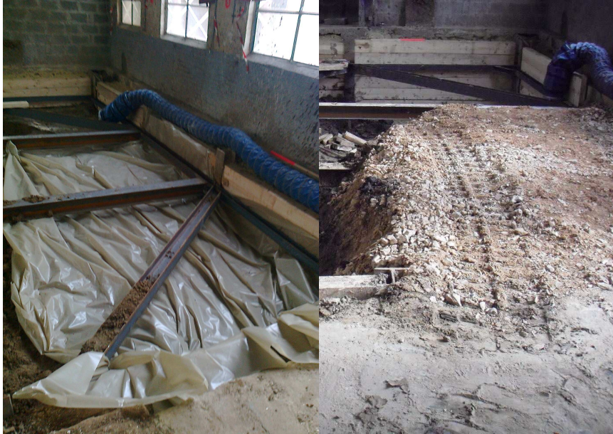
Figure 17 : Rampe d'accès à la zone Nord Est de la fouille
