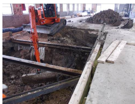
Vue de la pelle et de l'excavation
