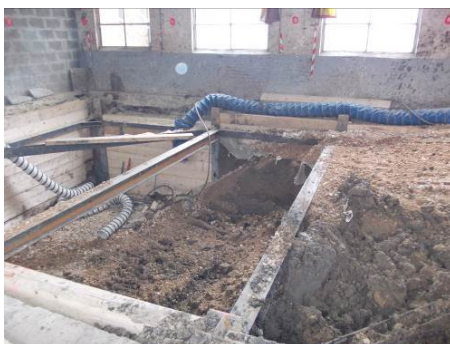
Vue de l'excavation
