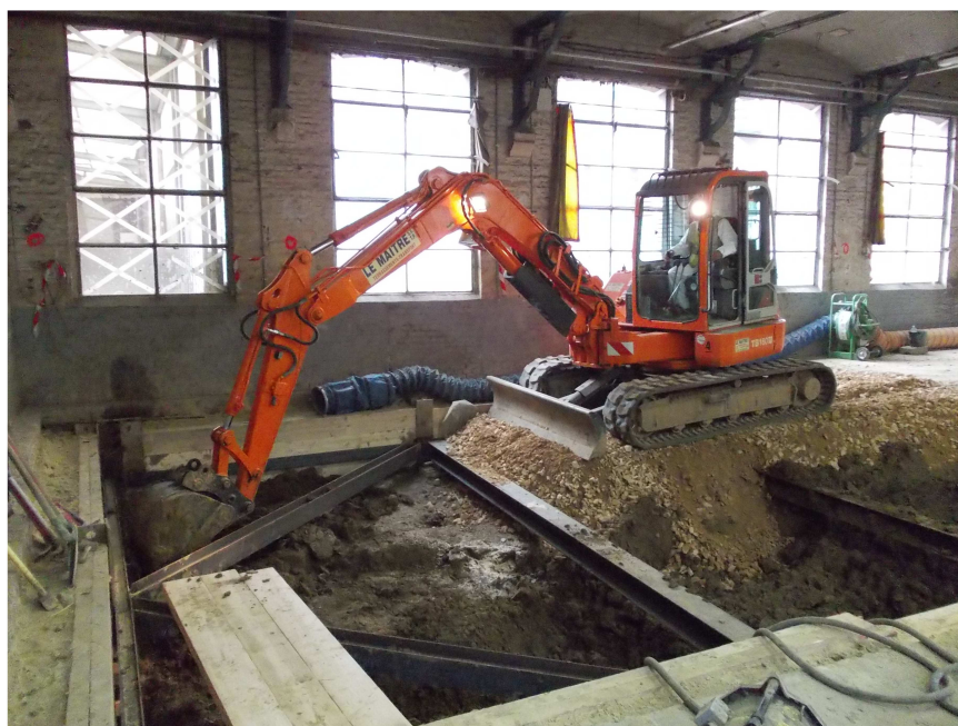
Figure 20 : Pelle mécanique en cours d'excavation
