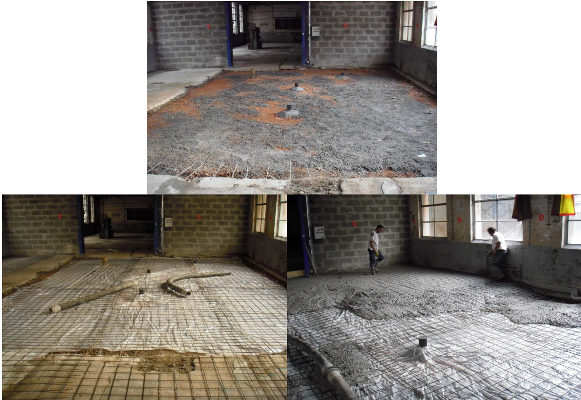
Figure 25 : Réfection de la dalle
