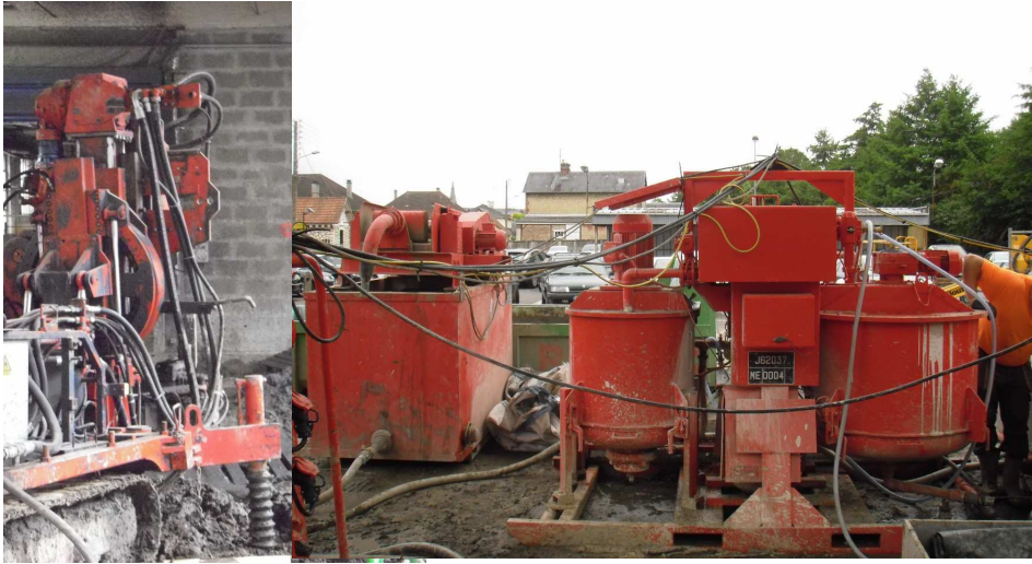
Figure 9 : matériel utilisé pour la réalisation des pieux bétons
