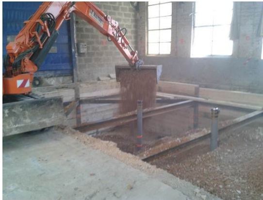
Vue du remblaiement
