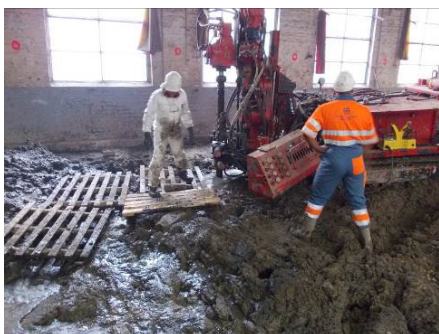
Vue de la mise en œuvre du soil mixing
