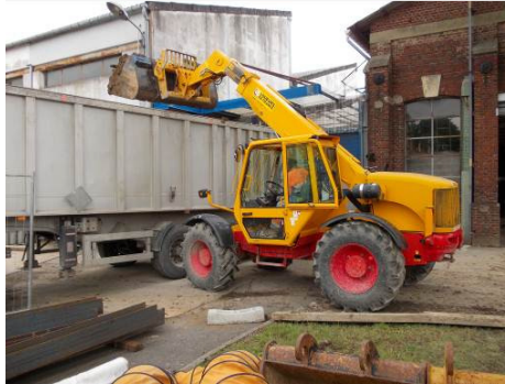
Chargement du camion (terres excavées)
