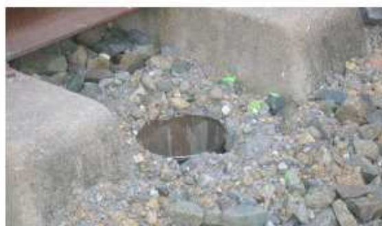
Figure 2 : tube de protection mis en place
